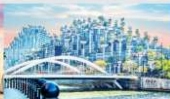
อาคารฟันทันไม
